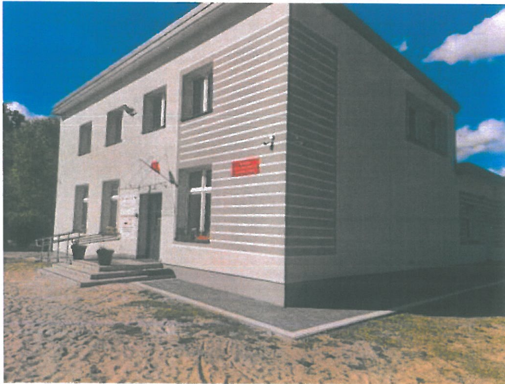
Remont budynku w Długiem – Centrum Usług Społecznych w gminie Czarnia
