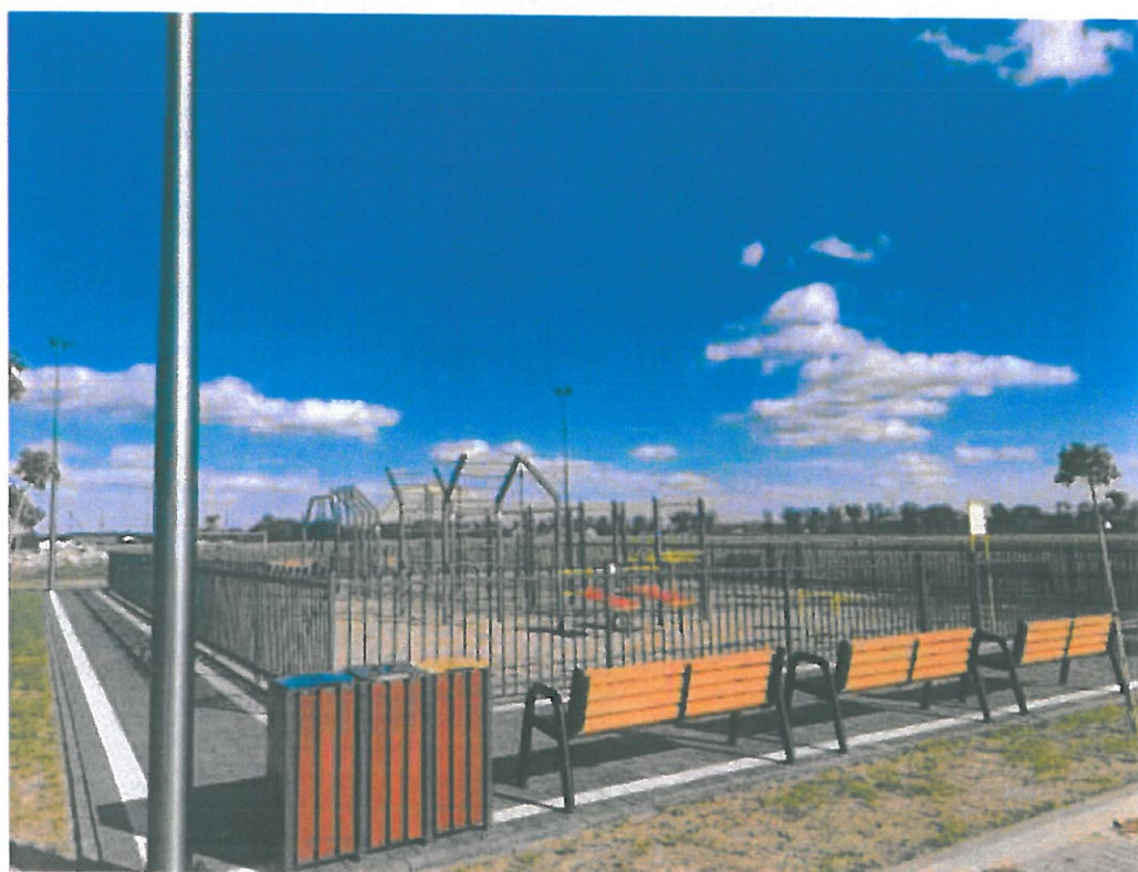
Budowa parku Street Workout wraz z terenem utwardzonym w m. Surowe
