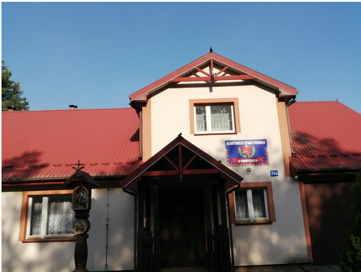
Rysunek: Modernizacja budynku Ochotniczej Straży Pożarnej w Bandysiach; PRZED:
